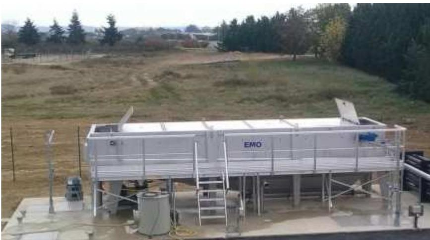
Une passerelle sera posée sur la largeur et la longueur de l'équipement pour faciliter l'accès.
