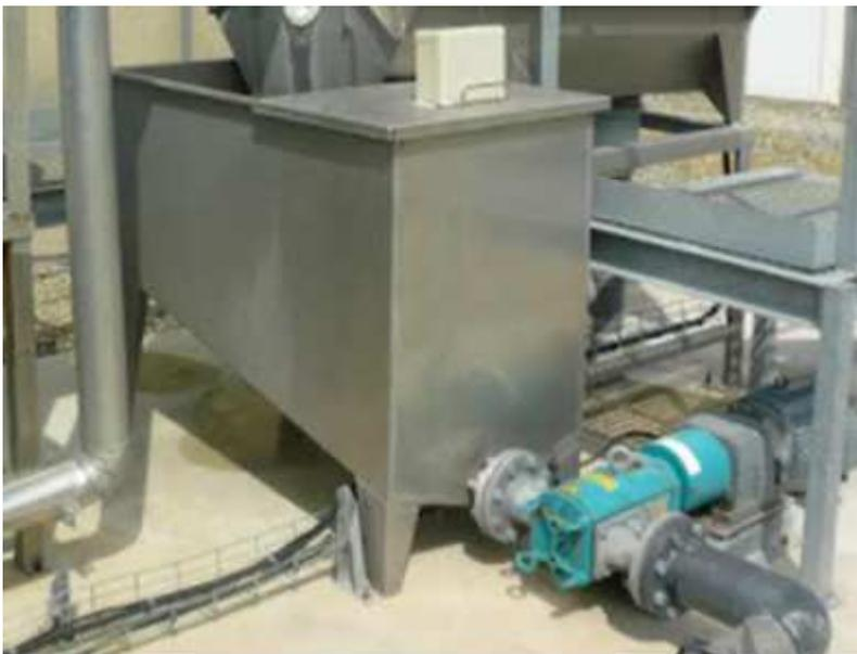
Exemple d'une pompe positionnée sous une trémie.
